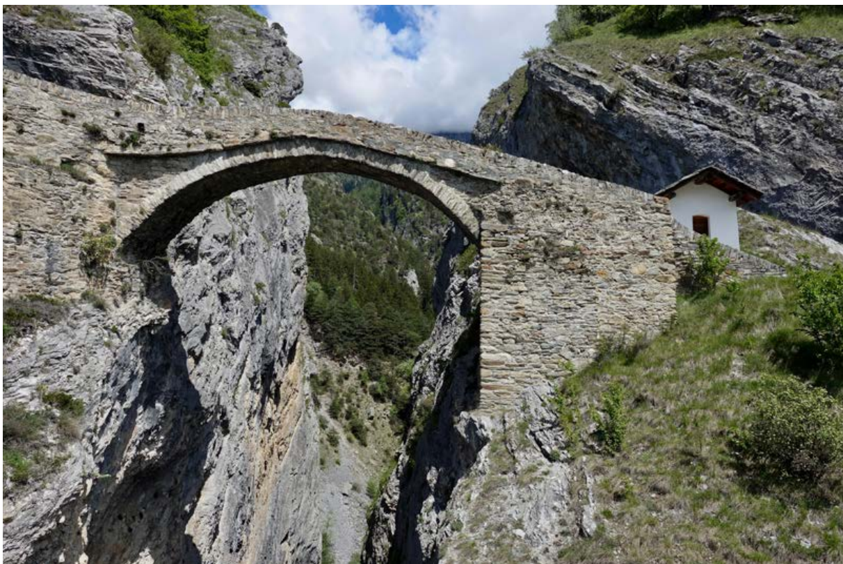
Die Hohe Brücke, wunderschön in die Schlucht gebaut (Ursula Ekkers).
